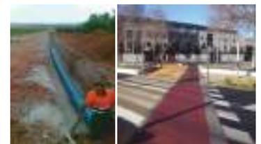
Microaglomerados asfálticos (lechadas bituminosas)
